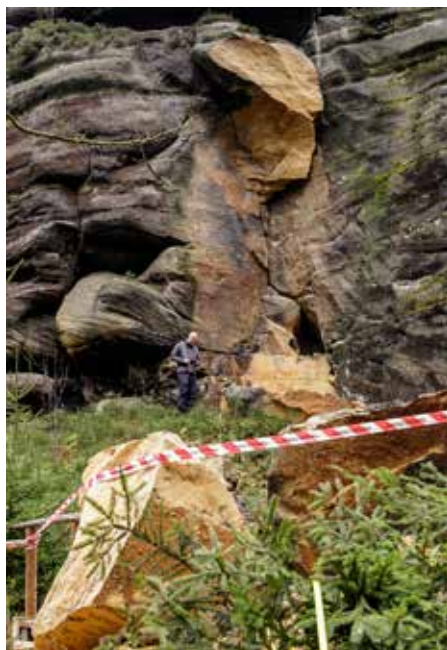
Fot. 4. Fragment piaskowcowego klifu odsłonięty w wyniku zawalenia się kolumny skalnej. W górnej jego części widoczny okap, w prawej-dolnej – kawerna. Poniżej ściany skalnej widoczne bloki zdeponowane podczas wystąpienia ruchu masowego (fot. K. Jancewicz).
