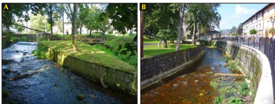
Ryc. 10. Kamienny Potok na obszarze miasta Szczytina: A – jaz kamienny z młynówką i ujęciem wody w centrum Szczytnej; B – obustronne kamienne mury oporowe oraz betonowa ostroga.
