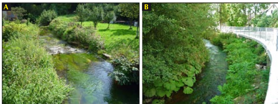
Ryc. 8. Kamienny Potok w Dłużynce: A – rozszerzenie koryta, na prawym brzegu widoczne fragmenty dawnych umocnień murem oporowym; B – prawostronne umocnienie koryta na zakolu, przy brzegu odsyp meandrowy porośnięty roślinnością.
